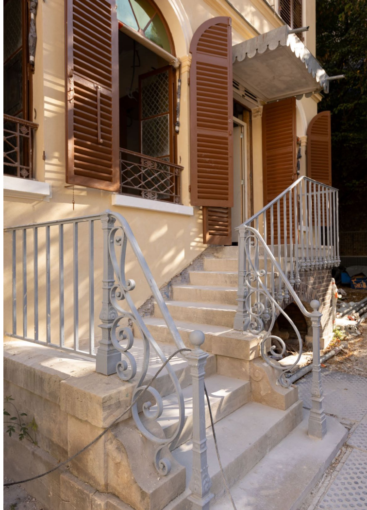
Vue du chantier du musée de la Vie romantique, septembre 2025 © Photo : Jean-Baptiste Gurliat / Ville de Paris
