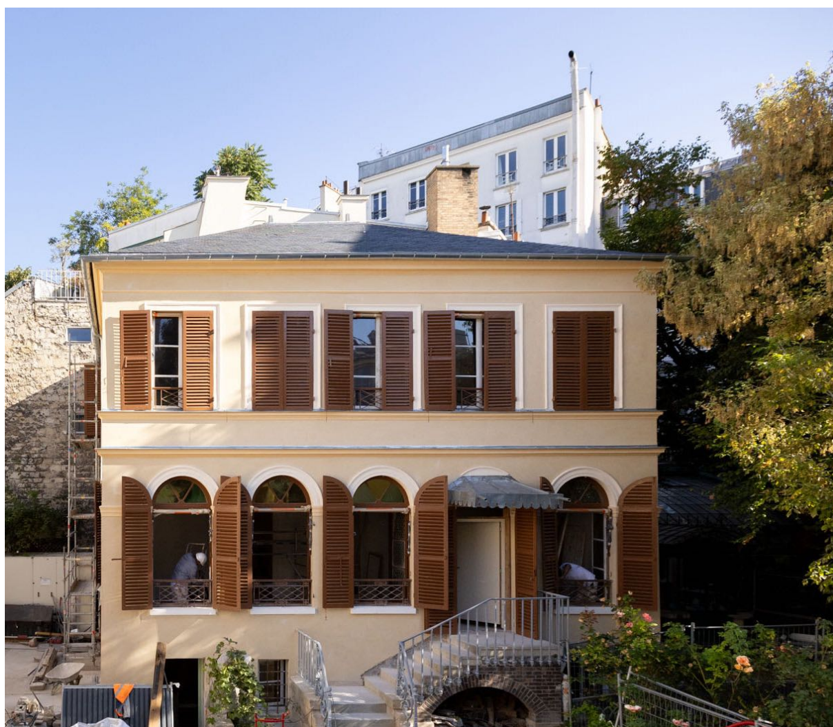
Vue du chantier du musée de la Vie romantique, septembre 2025 © Photo : Jean-Baptiste Gurliat / Ville de Paris
