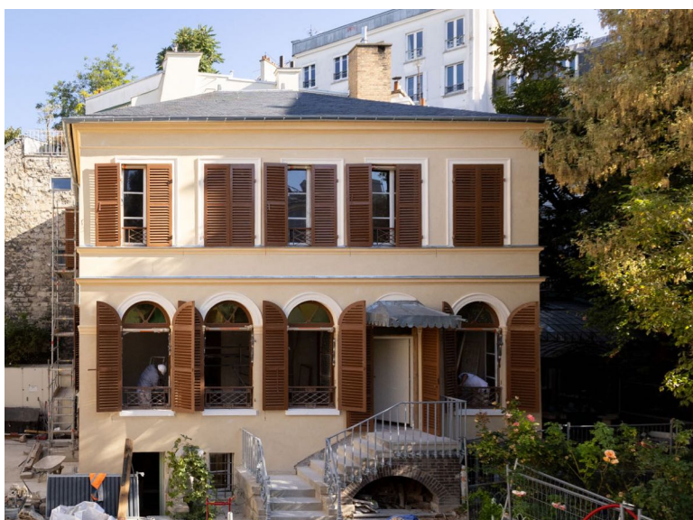
Vue du chantier du musée de la Vie romantique, septembre 2025 © Photo : Jean-Baptiste Gurliat / Ville de Paris
