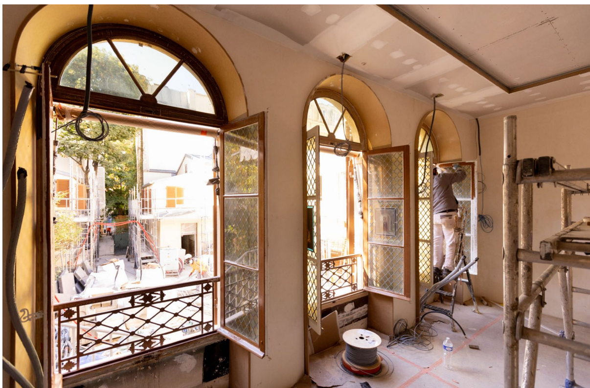
Vue du chantier du musée de la Vie romantique, septembre 2025 © Photo : Jean-Baptiste Gurliat / Ville de Paris
