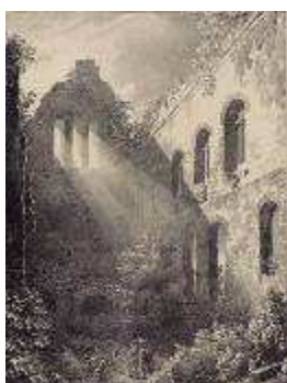
2. Alexandre-Évariste Fragonard (1780-1850), Vue intérieure des ruines de la grande salle du château d'Harcourt , 1820. Voyages pittoresques et romantiques dans l'ancienne France , Ancienne Normandie, 1820. © Paris, Fondation Taylor / Thomas Hennocque
